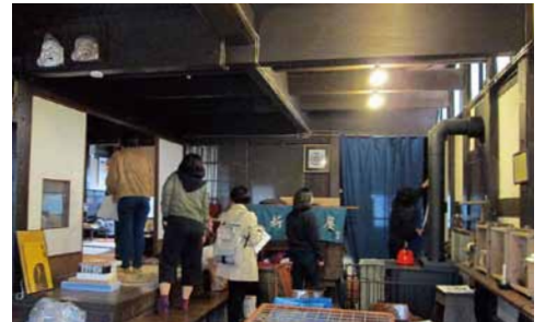
「被災建物の調査の様子」
